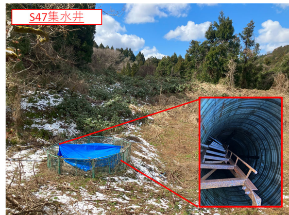
写真1 昭和47年施工・鋼製集水井
